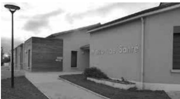
Onze professionnels de santé occupent désormais le bâtiment.
