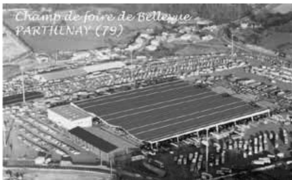
La toiture du Marché aux bestiaux sera entièrement recouverte de panneaux photovoltaïques.
