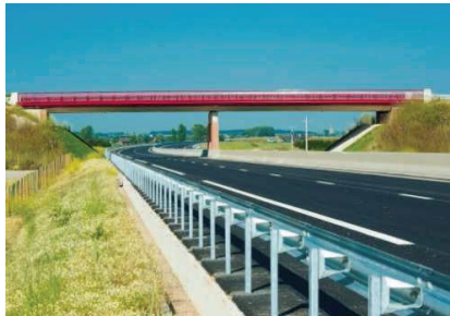
Contournement Borre-Pradelles (RD642) - HQE
