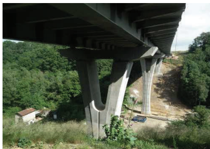
Le Châtelet Sur Sormonne –A 304 – Viaduc
