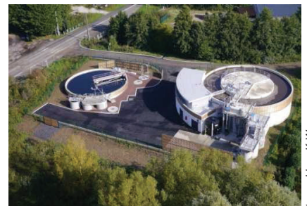
Saint Paul – Station d'épuration 5 000 E.H.
