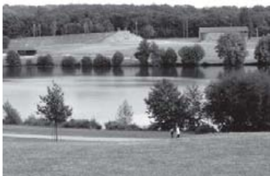
Vue de la passerelle côté Uzurat
