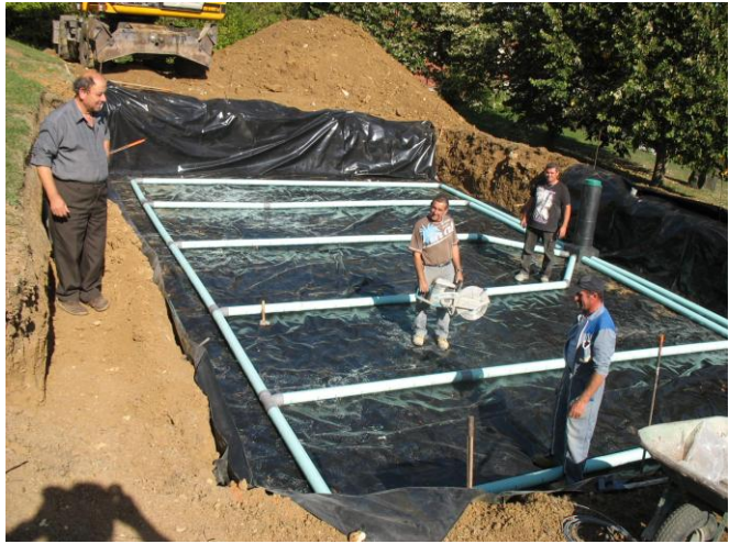
Travaux d'assainissements des bâtiments communaux
