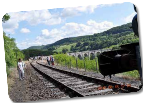
Promenade sur le viaduc
