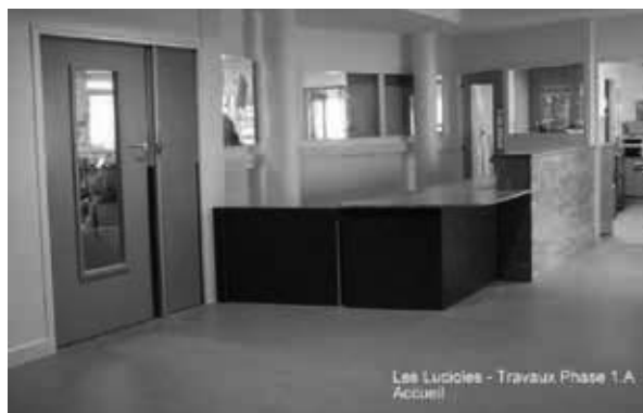
Un nouvel espace d'accueil comptabilité a été installé
