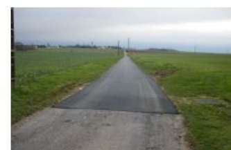
Hameau de la Bonnière : Renforcement de la chaussée ;
