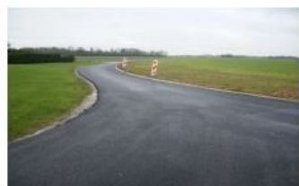
Hameau de Gloise : Pose de bordures et renforcement de la chaussée ;
