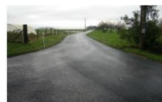
Hameau de la Berge : Renforcement de la chaussée ;
