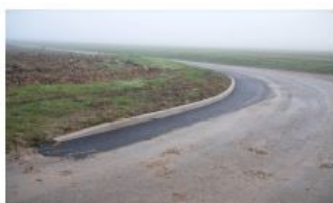
Hameau du Jariel : Pose de bordures et renforcement de la chaussée ;
