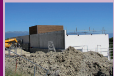
Construction de la chaufferie collective
