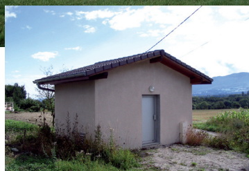
Réservoir des Rosats et surpresseur de l'Eluiset
