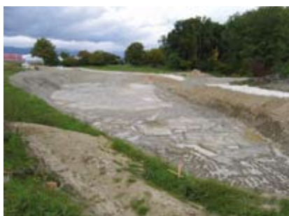
Bassin de rétention destiné à tamponner les eaux pluviales en périodes de fortes précipitations
