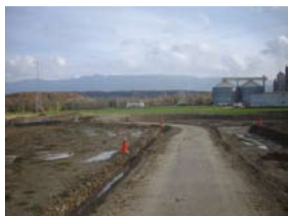
Décapage des futures voiries et mise en place d'un matériau de remblai traité à la chaux.
