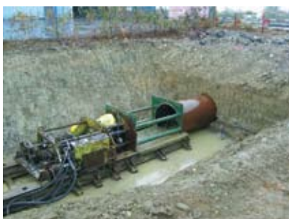
Fonçage sous les voies ferrées pour passer une canalisation de diamètre 1000
