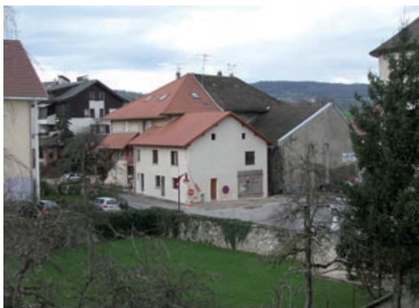
Réfection du toit et de la façade de la Maison « Vy Darri » accueillant l'A.D.M.R. et les chantiers d'insertion AGIRE. Coût : 15 630 €
