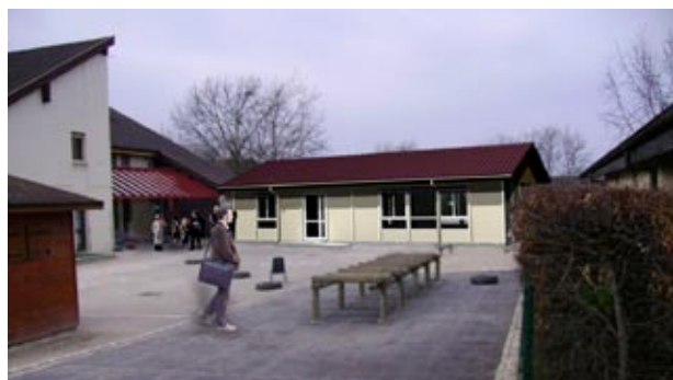
Des travaux ont lieu, actuellement, dans la cour de l'école maternelle afin de pouvoir déposer une construction modulaire, raccordée au bâtiment principal par un sas. Ce bâtiment accueillera la cinquième classe de l'école maternelle située au rez de chaussée de l'école primaire. Cette structure sera installée dans le premier trimestre 2007 pour un coût total estimé à 155 000 € TTC.
