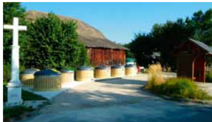
Les 7 conteneurs à déchets semi-enterrés aux Perriers
