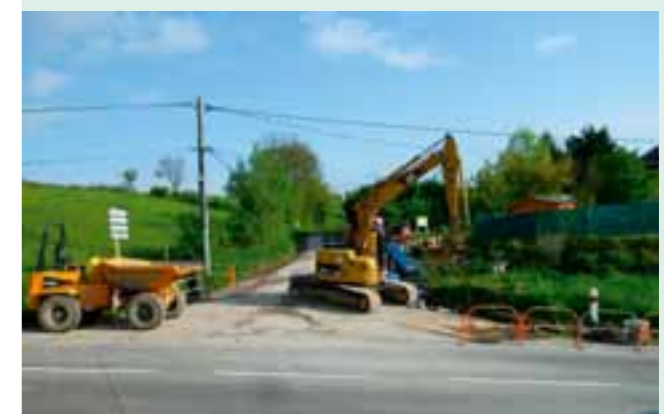
Réalisation du collecteur d'eau potable aux Perriers
