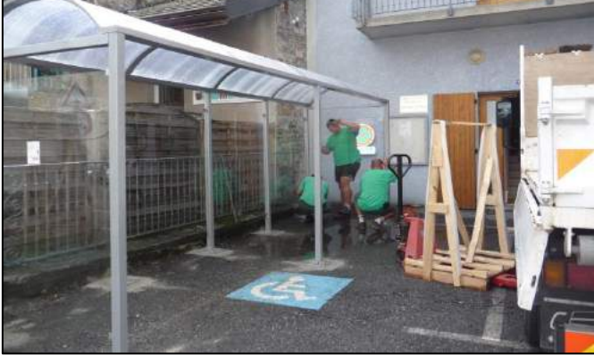
Abri bus mis en place par les agents communaux
