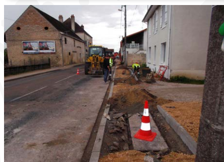
Grande rue pendant les travaux
