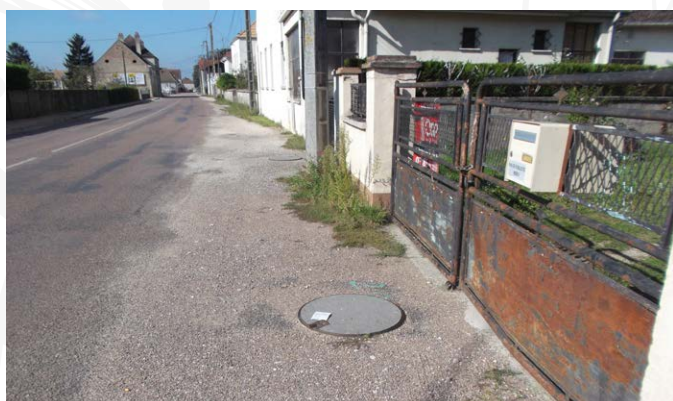
Grande rue avant travaux trottoir
