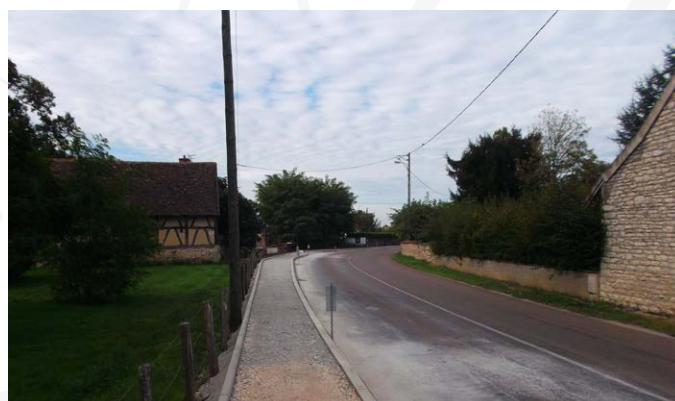
Grande rue après travaux trottoir
