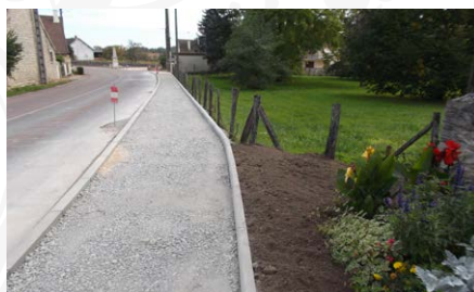
Grande rue après les travaux
