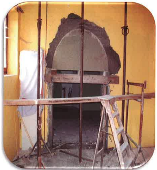
Pendant les travaux
