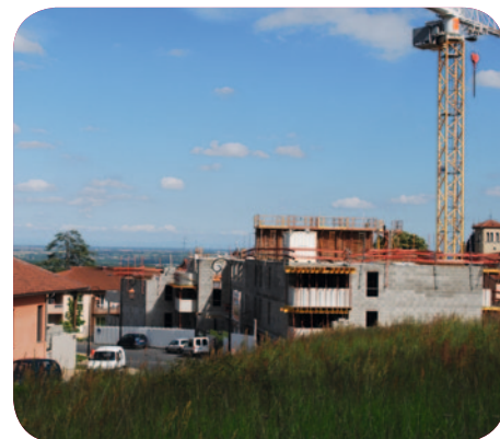
Immeuble L'Orée du Bourg en construction
