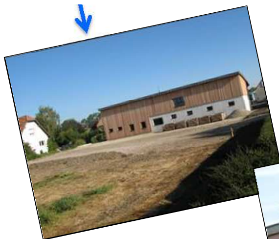
Agrandissement du parking de la salle des fêtes
