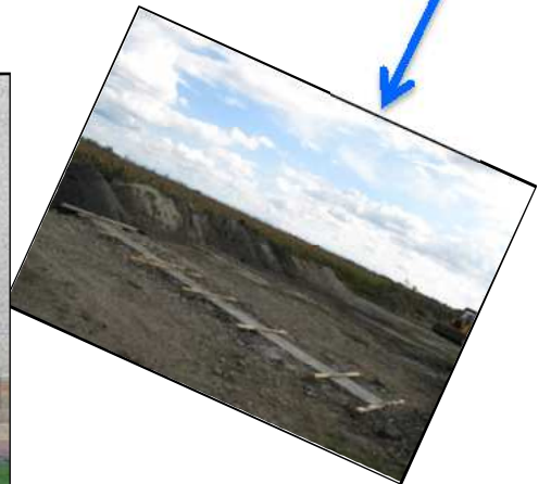
Mise en place d'une barrière route de Jepsheim
