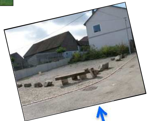
Pose d'enrochement rue de l'Ischert
