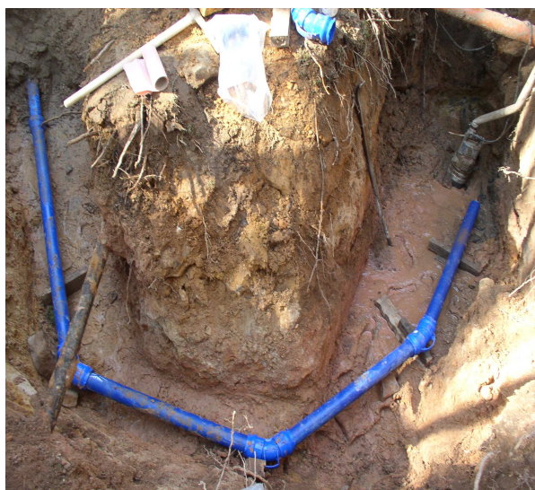
Nouvelle conduite à la sortie de la
