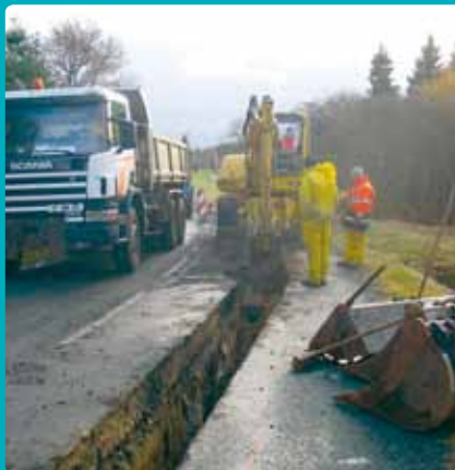
Nouvelle conduite sur 2 km entre Marcenat et le Thiolet
