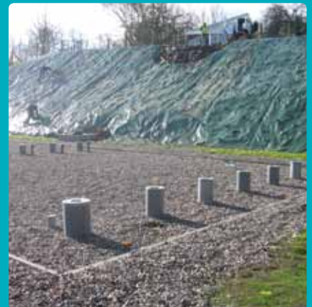
Station d'épuration La Coussedière
