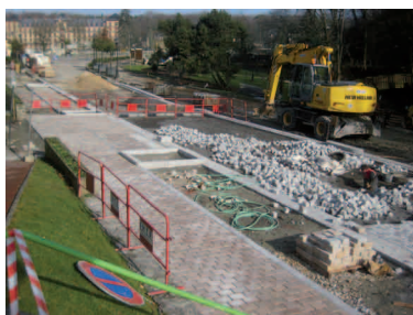
Démarrage des travaux rue du Pr Louvel
