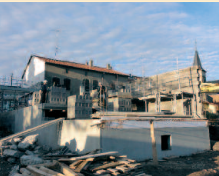
Le chantier de la bibliothèque
