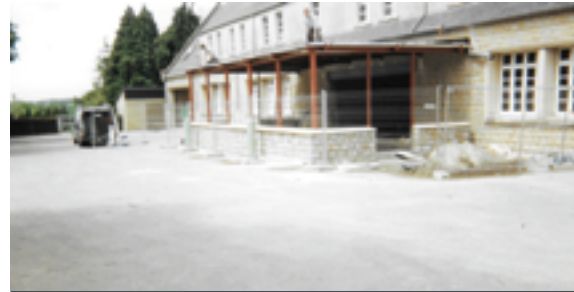
1999 : Construction de la cantine
