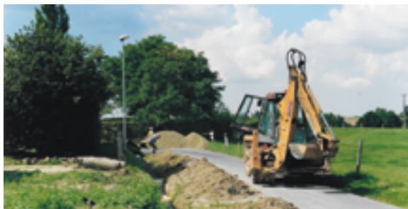
2002 : réseau d'eaux pluviales, planche de la Sée
