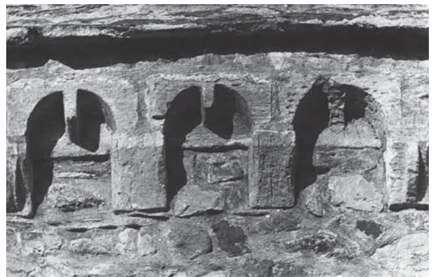
Figure 7 - Détail d'un fragment de corniche dite "beauvaisine"
