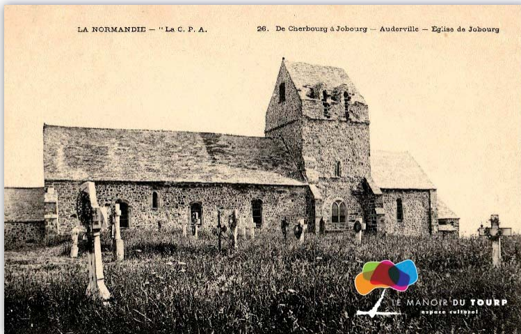
Figure 2 - La chapelle détruite était construite entre les deux contreforts et adossée au clocher de l'église. Sur cette carte postale, on remarque de nombreuses croix en bois aujourd'hui disparues.
