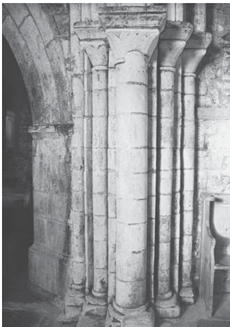
Figure 5 - Articulation d'un des piliers du chœur
