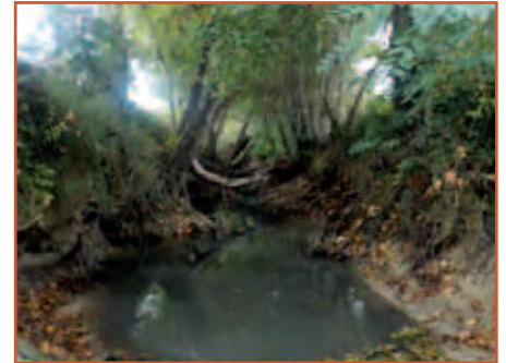
Secteur non restauré : végétation mal implantée et glissante
