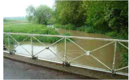
Pont sur la Poterie - route du Fort
