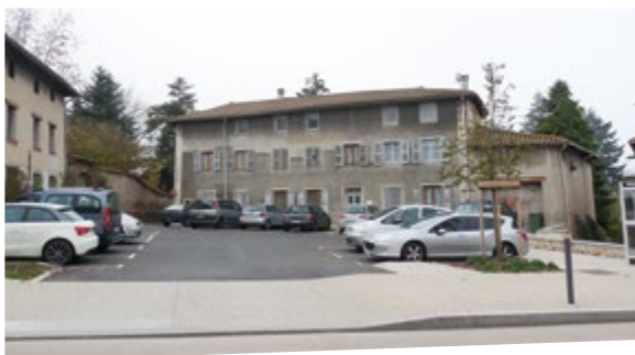
Fin des travaux du bourg en particulier aménagement paysager de la place des Tilleuls et de son parking
