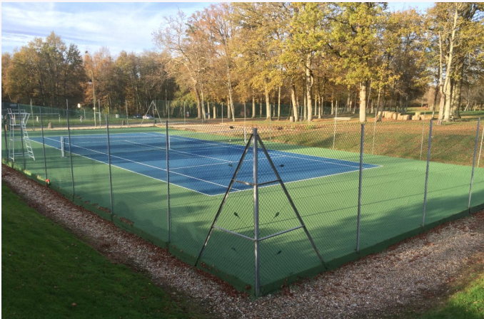
Le court de tennis rénové
