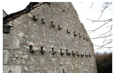
Pignon sud du moulin de Rechevet
