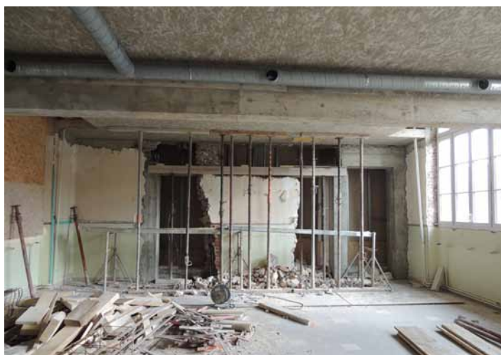
Le chantier de l'extension de la médiathèque.
