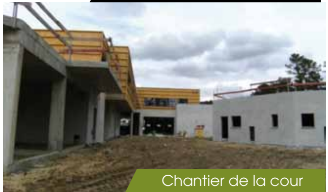
Chantier Façade principale
