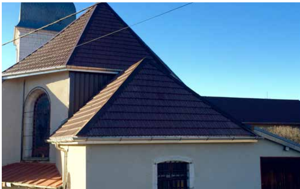
La sacristie est désormais protégée des infiltrations depuis la toiture
