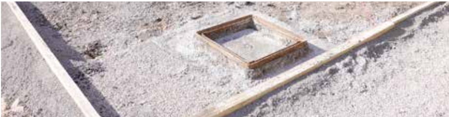
Une dalle béton a été coulée pour protéger la citerne voûtée vers la mairie
