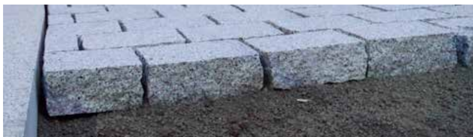
Les pavés granit rectangulaires ont été installés avec soin
