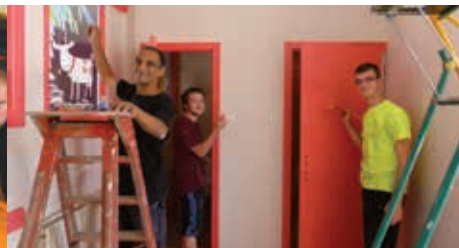
Rénovation : peinture à la crèche.
