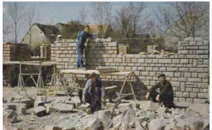
Chantier taille de pierre (Marc Pelletier)
