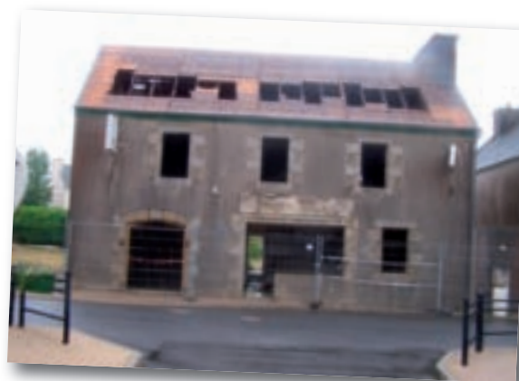
Photo prise en cours de déconstruction
