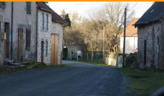
Travaux de voirie à Fournoué
