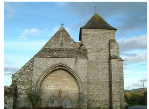
Chapelle St Jacques : les travaux avancent
