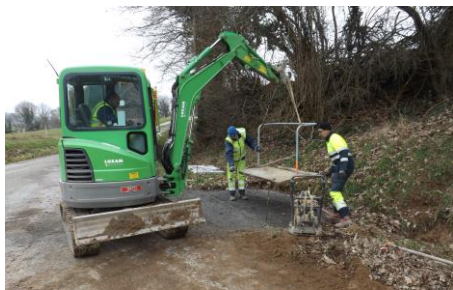
Mise en place des nouvelles plateformes pour les conteneurs
