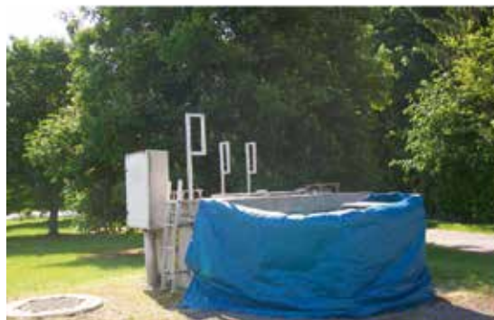
Poste de refoulement à réhabiliter (Poncey-les-Athée)
