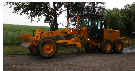
Passage de la niveleuse sur la route des Flottes
