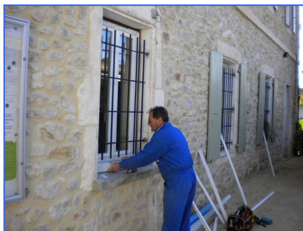
Réfection des menuiseries
