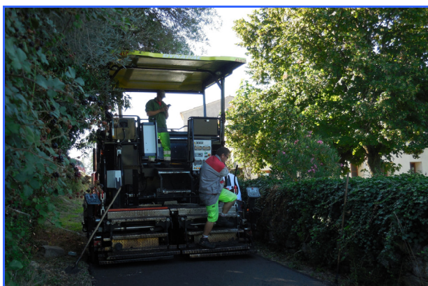
Travaux de goudronnage
