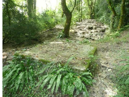
L'ancien captage de Monitieu
