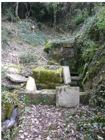
L'ancien captage de MURS
