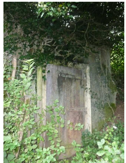
L'ancien réservoir de Gelignieux
