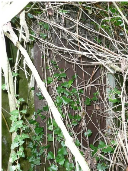
L'ancien réservoir de Monitieu
